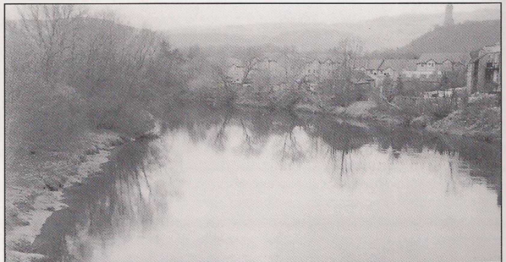
El río Forth en Stirling. Los restos de la estructura del puente original son a veces visibles debajo de la superficie cuando disminuye el caudal del río. Al fondo, a la derecha, está Abbey Craig, coronado por el monumento a
